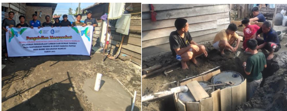
Gambar 5. Pembuatan Drumpicon Percontohan
